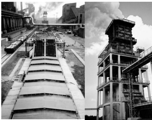
Rys. 4. Osadnik płytowy, przeciuprądowy do oczyszczania wód po wieży gaszenia koksu w ZK Zdieszowice [4]
